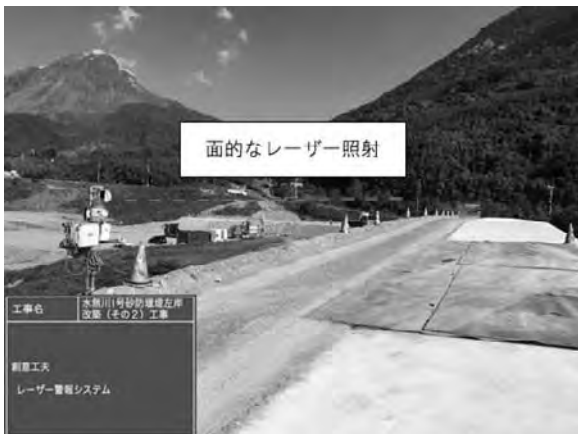
図-5 レーザーセンサーと警報機
