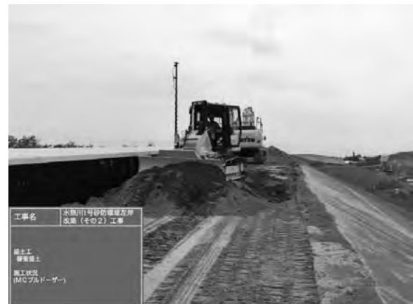
図-4 緩衝盛土ICT施工状況
