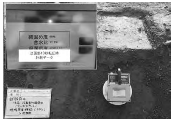
図-6 SDGによる計測状況
