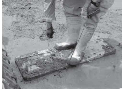
図-5 実工事における作業状況
